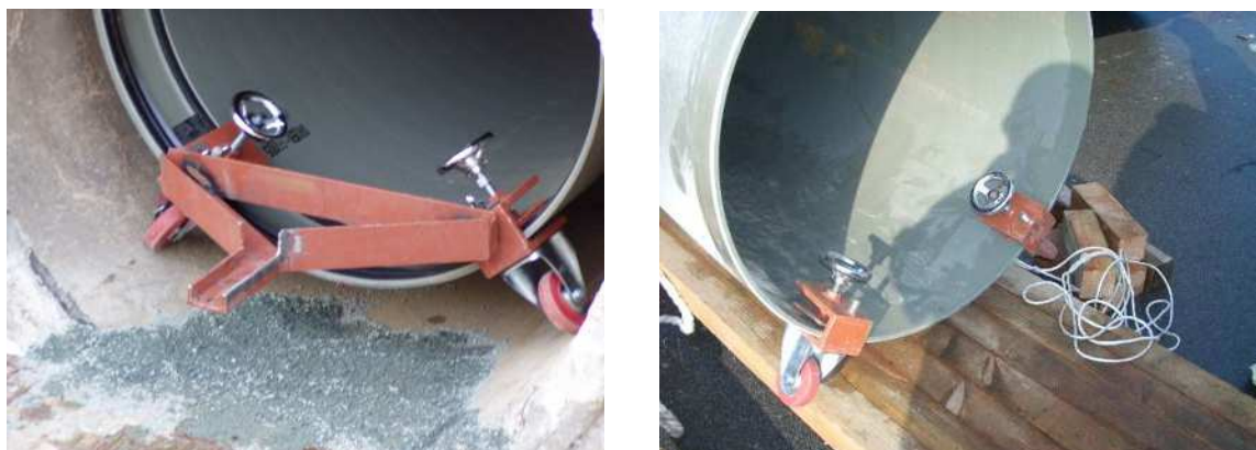
図 2-3-3 管に車輪取り付けの例
